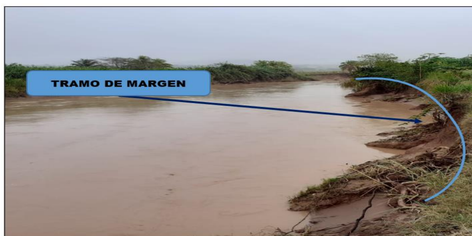
FIGURA N°02.- TRAMO CRÍTICO EN EL RIO SISA, EN DONDE POR EROSION FLUVIAL SE PONE EN RIESGO INFRAESTRUCTURA DE RIEGO ( Canales de primer Orden), QUE ABASTECEN DE AGUA PARA RIEGO A LOS AGRO CULTORES DE LA ZONA
