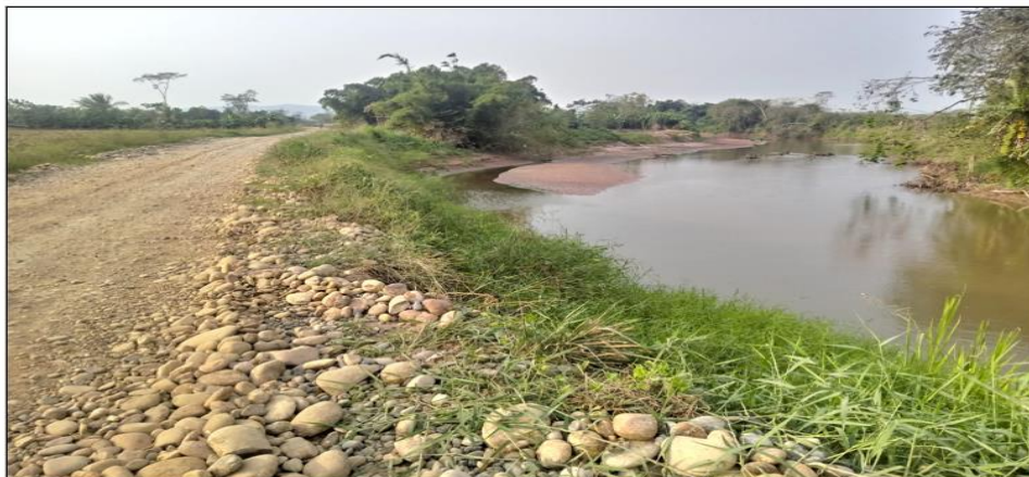
FIGURA N°01: TRAMO CRÍTICO EN EL RIO SISA, EN EL SECTOR CARHUAPOMA, PONIENDO EN PELIGRO EL COLAPSO DE LAS VIAS DE ACCESO A LA AREAS DE PRODUCCION, POR LA EROSION FLUVIAL EN MAXIMAS AVENIDAS.
